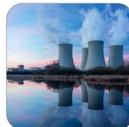
Системы охлаждения воды
