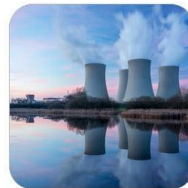
Системы охлаждения воды
